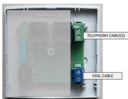
Le port RJ11 marqué pour la téléphonie (à droite du NTP) ne peut être utilisé que lorsqu'un câble de téléphonie est installé entre le modem (sortie VoIP) et les bornes vertes du NTP.
